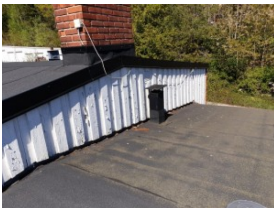
Färgsläpp på träpanel, här på gavelspets.
