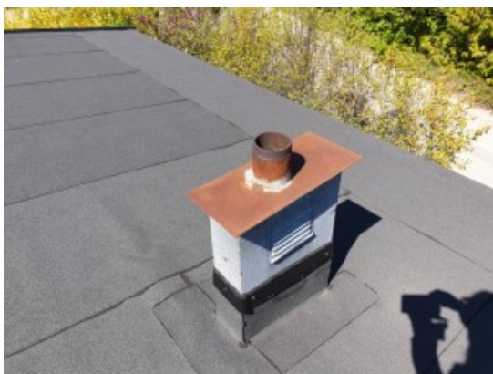
Rostangrepp på plåthuvar.
