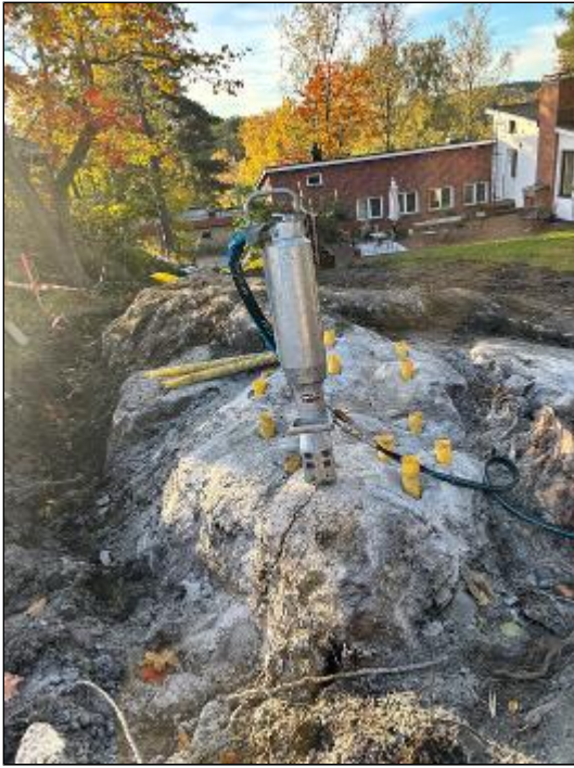
Hämtat spräckutrustning, samt material, börjat spräcka berg
