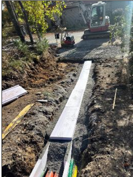
Fixat dagvatten rör, mont värmekabel på vatten rör, fyllt upp med stenmjöl runt div rör, fixerat brunnar för spolbrunnar och av/på vatten, paddat och lagt ut material för väg
