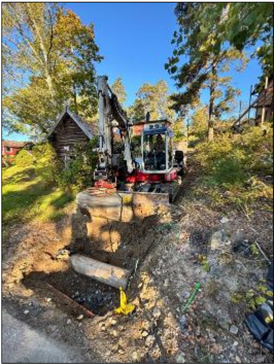
Grävt fram avlopp och inkommande vatten, kört bort massor med dumper
