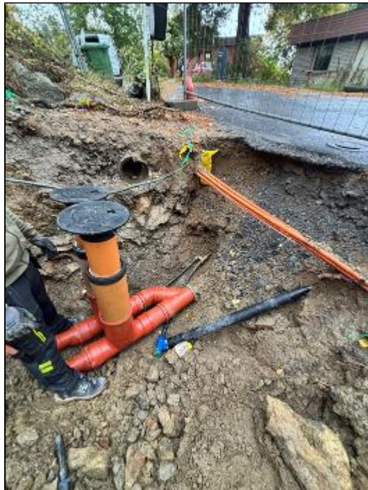
Kopplat på vatten och avlopp, mont spolbrunnar vatten avstängare, fyllt med stensmjöl, grävt upp schakt, sandat i schakt
