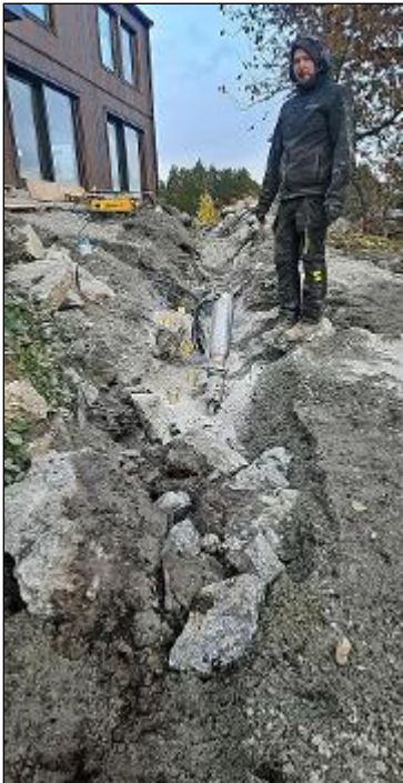
Borrat spräckt berg och rivit för vatten avlopp el och fiber
