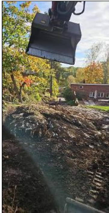
Grävt fram berg, kört bort massor, tagit emot material, lagt stenmjöl i schakt och jämnat ut, byggt frigolitlåda
