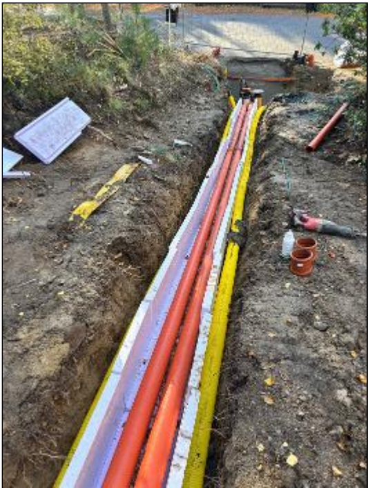
Dragit el rör, fibernät , avloppsrör
