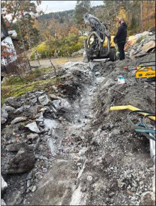
Borrat spräckt berg och rivit för vatten avlopp el och fiber
