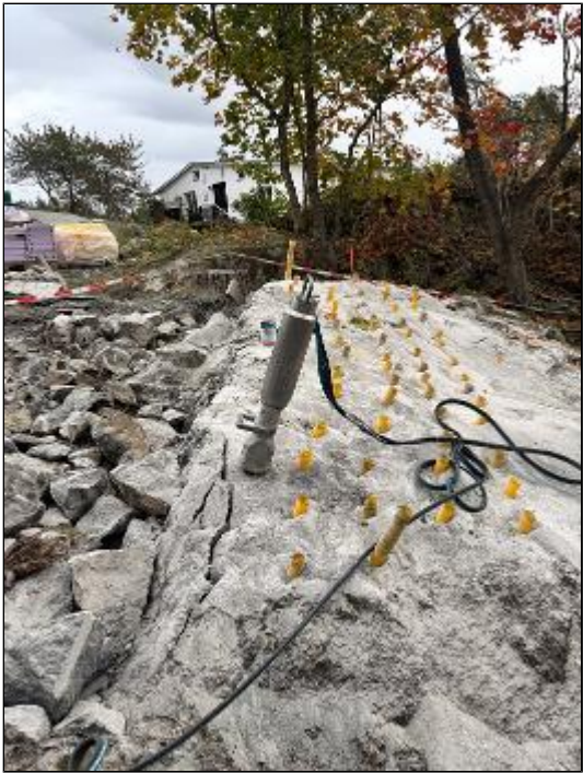
Borrat, spräckt och rivit berg, fyllt med stenmjöl i schakt
