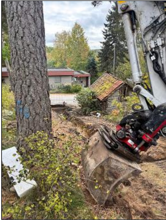
Grävt upp för vatten avlopp fiber och el, kört med dumper och dumpat material
