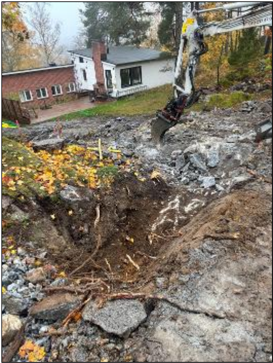
Borrat spräckt rivit berg, byggt frigolit låda dragit rör vatten fiber och el
