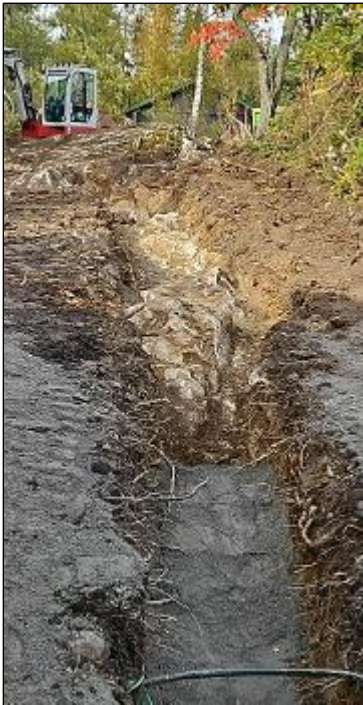
Grävt fram berg, kört bort massor, tagit emot material, lagt stenmjöl i schakt och jämnat ut, byggt frigolitlåda
