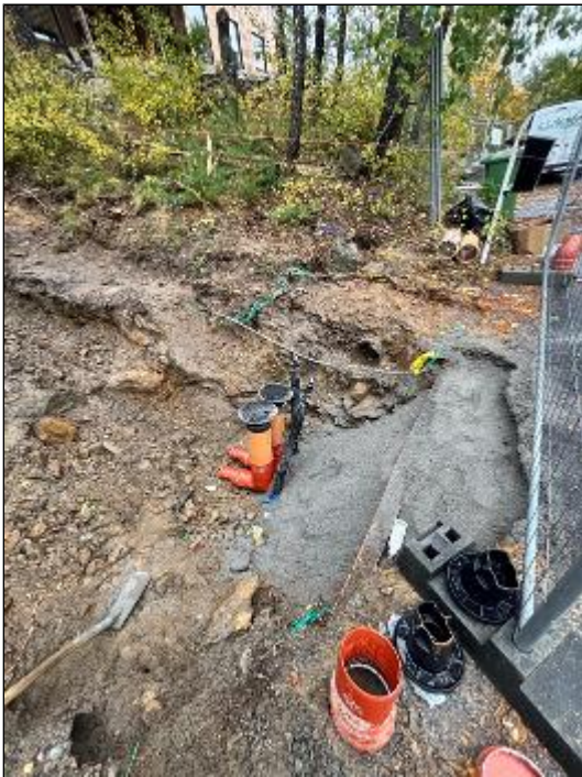
Kopplat på vatten och avlopp, mont spolbrunnar vatten avstängare, fyllt med stensmjöl, grävt upp schakt, sandat i schakt
