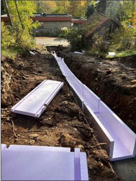
Grävt fram berg, kört bort massor, tagit emot material, lagt stenmjöl i schakt och jämnat ut, byggt frigolitlåda
