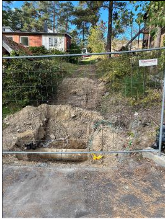
På etablerat, haft byggmöte med kund, grävt ur och fram för vatten avlopp el och fiber
