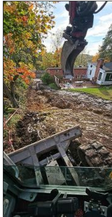
Grävt fram berg, kört bort massor, tagit emot material, lagt stenmjöl i schakt och jämnat ut, byggt frigolitlåda
