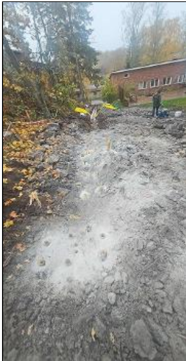
Borrat spräckt rivit berg, byggt frigolit låda dragit rör vatten fiber och el
