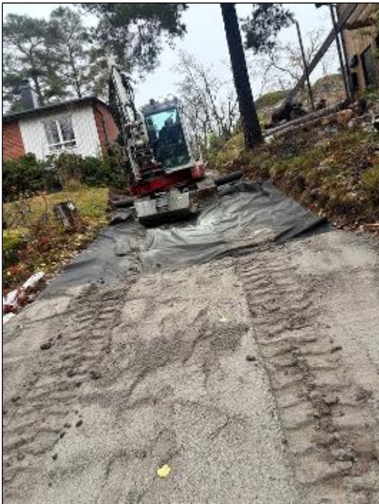
Monterat frigolitlåda, mont avlopp, el, fiber, värmekabel på vatten, fyllt igen med stensmjöl, förberett för väg
