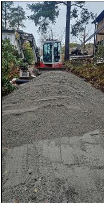
Grävt upp schakt för dragning, byggt frigolitlåda, fyllt igen över låda
