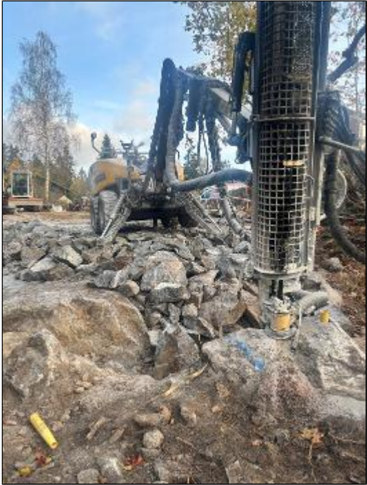
Borrat spräckt och rivit berg för isoleringslåda och dragit rör, el fiber vatten, bajs, byggt låda
