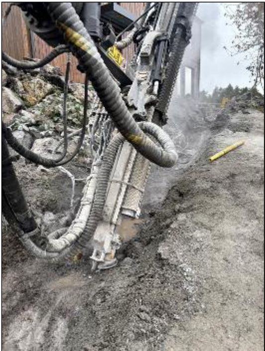
Borrat, spräckt och rivit berg för vatten och avlopp, el fiber
