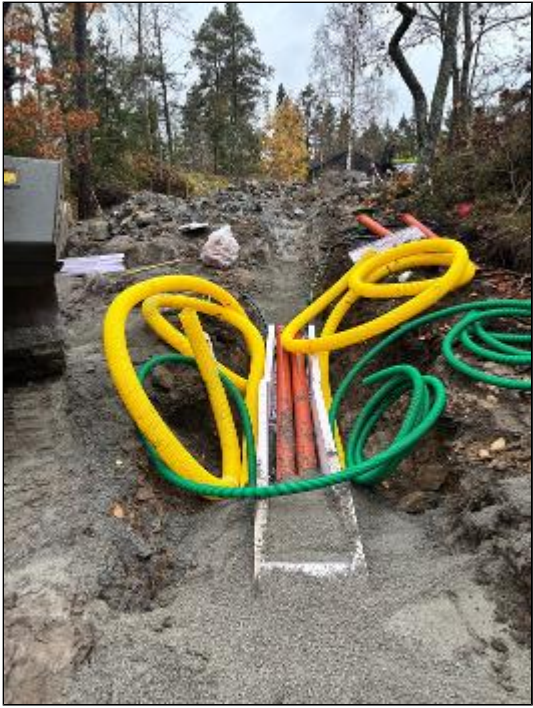
Grävt upp schakt för dragning, byggt frigolitlåda, fyllt igen över låda
