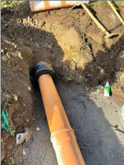
Fixat dagvatten rör, mont värmekabel på vatten rör, fyllt upp med stenmjöl runt div rör, fixerat brunnar för spolbrunnar och av/på vatten, paddat och lagt ut material för väg
