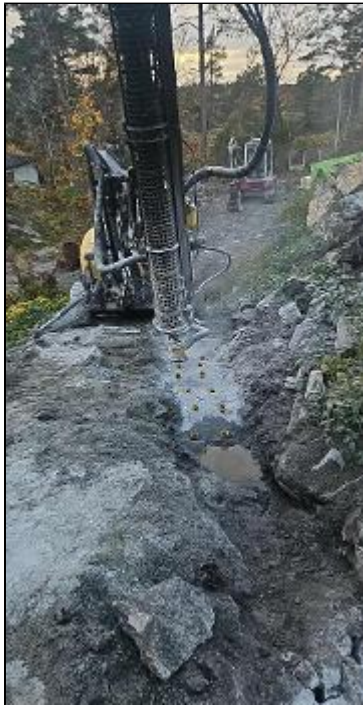
Borrat spräckt berg och rivit för vatten avlopp el och fiber
