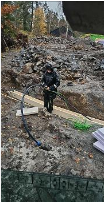
Grävt upp schakt för dragning, byggt frigolitlåda, fyllt igen över låda
