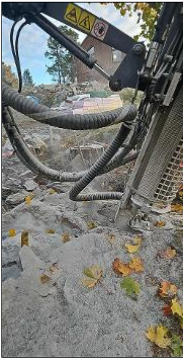
Borrade ca 130 hål. Spräckte ca 1/4 och rev med grävmaskinen.
