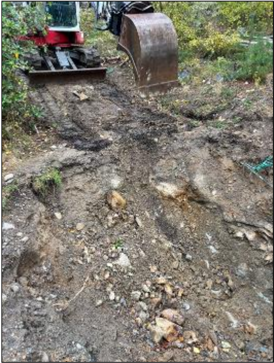
Grävt upp för vatten avlopp fiber och el, kört med dumper och dumpat material
